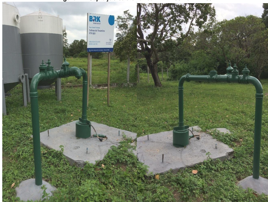
Figura 11. Captação subterrânea – PTP-001 e PTP-002
