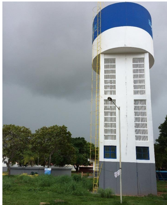
Figura 17. REL 001 e RSE 001 – Centro de Reservação Central
